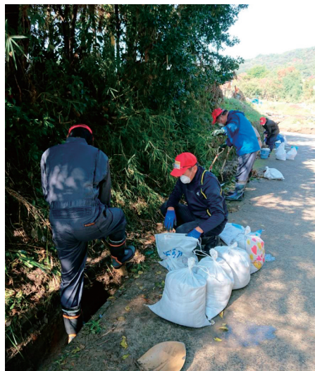
側溝の泥出しの様子
