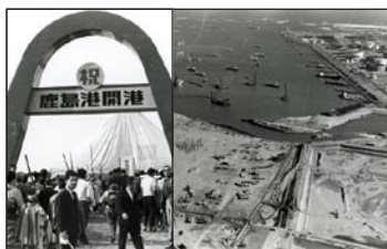
鹿島港開港 (昭和 44 年)
