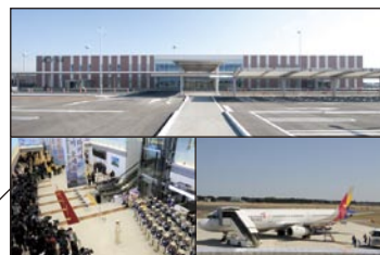
茨城空港 (平成 22 年)
